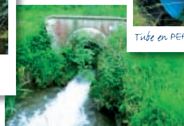
Accélération de l'écoulement = érosion des berges en aval et blocage des espèces aquatiques
